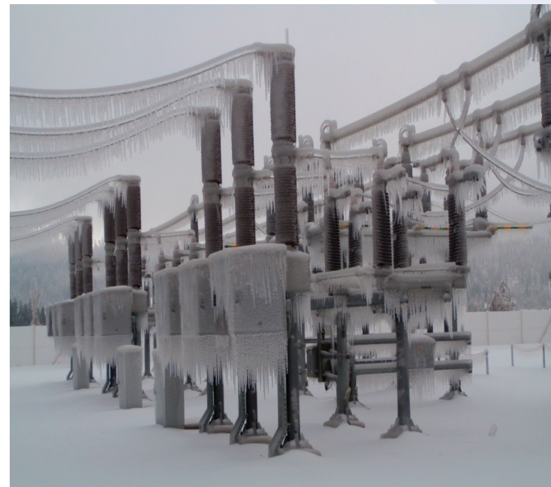
Led na elektro infrastrukturi
